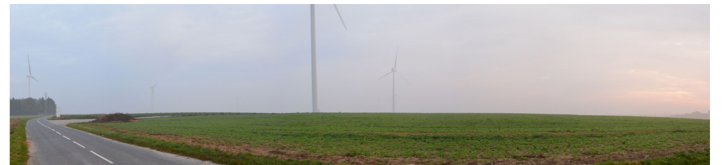
PHOTO 19 : LE PARC ÉOLIEN DE NURLU (© AGENCE COÛASNON)
